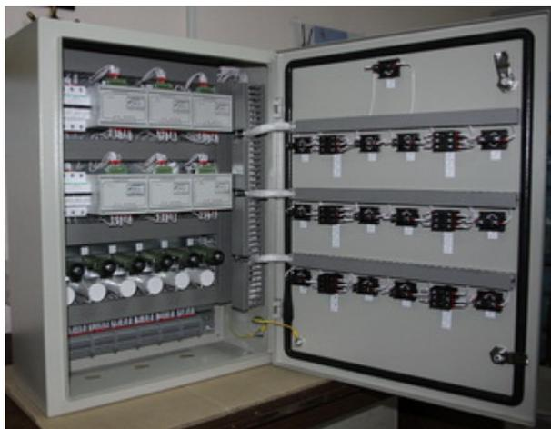
Блок управления исполнительными механизми (БУМ) предназначен для бесконтактного управления электрическими исполнительными механизмами. Область применения: системы автоматического регулирования технологическими процессами в энергетической и других отраслях промышленности.
